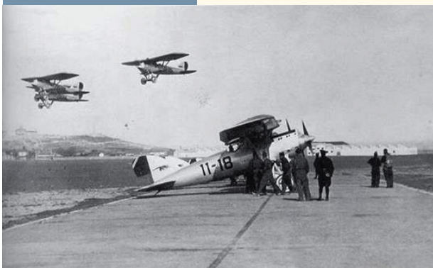
1936 movimiento de aviones Nieuport 52 en Getafe
